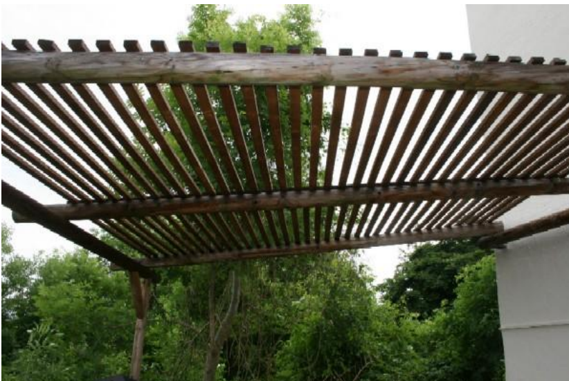
Abb. 1: Sehr kostengünstig, funktionsgerecht und dauerhaft sind Beschattungen aus Holz-latten.
